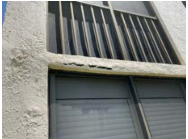
Edge cracks
