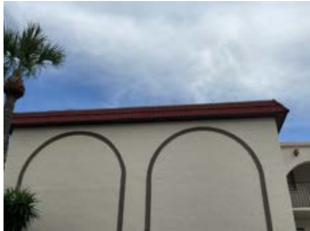
Metal tile at roof edge
