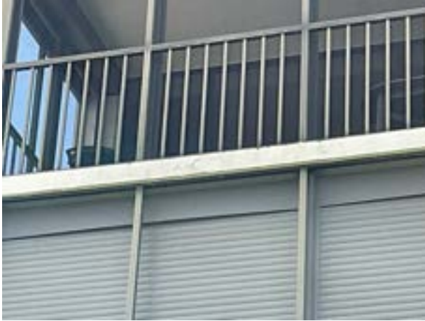
Stucco at balcony edge
