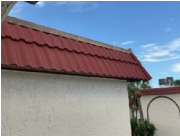
Metal tile at roof edge
